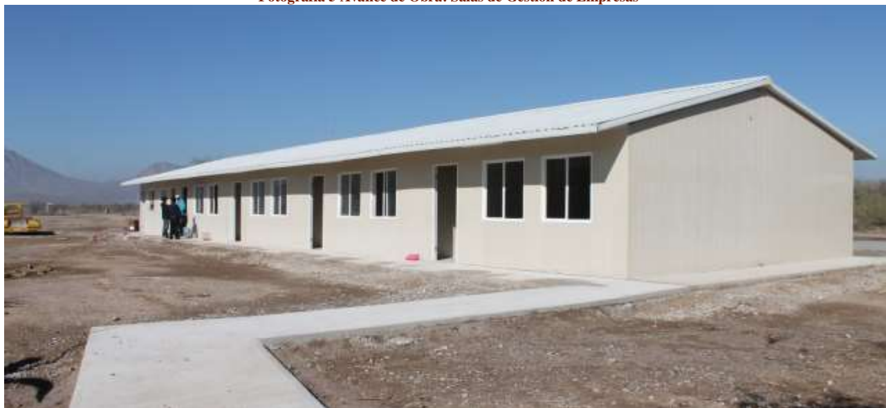
Fotografía 5 Avance de Obra: Salas de Gestión de Empresas
