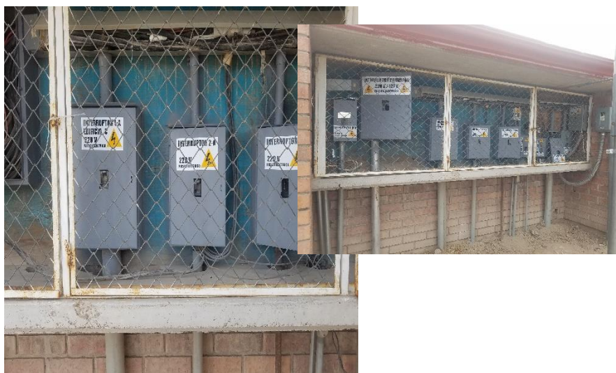
Etiquetado de centros de carga eléctrica
